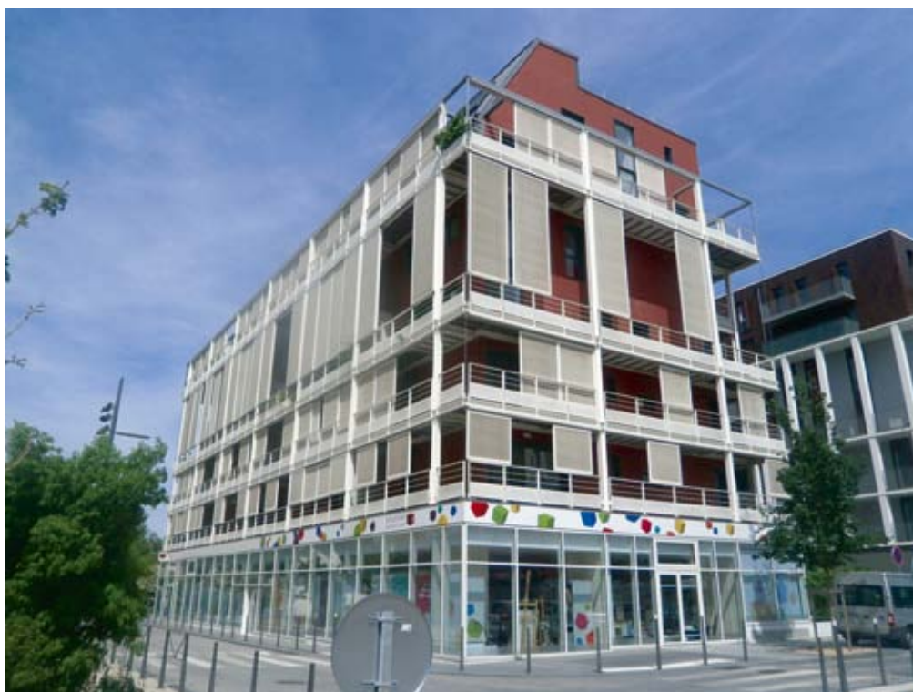
Protections Solaires, ZAC du Bon Lait (7 ème arrondissement)
