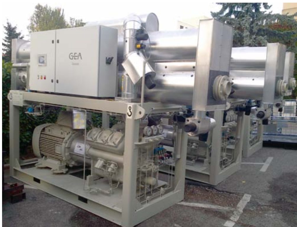
Rénovation des groupes froids Patinoire Baraban (3 ème arrondissement)
