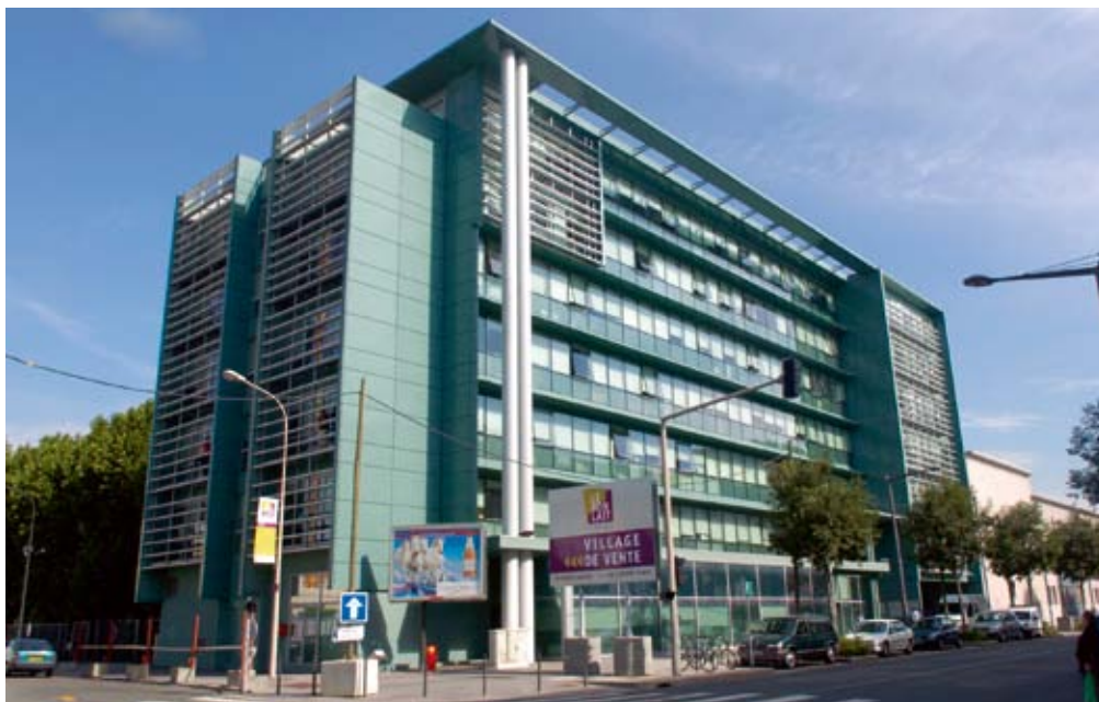
Immeuble administratif Jaurès (7 ème arrondissement)
