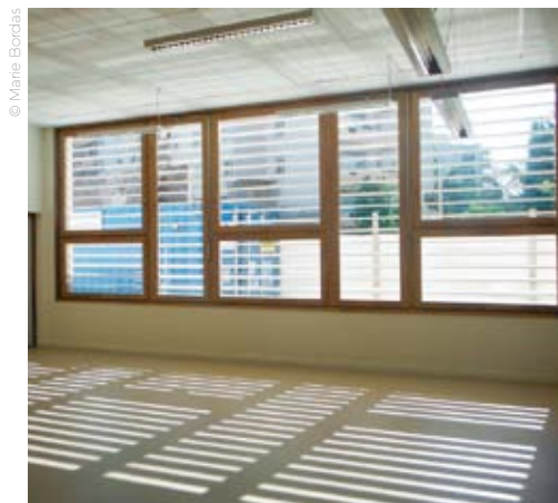
Protections solaires de l'école Marie Bordas (8 ème arrondissement)
