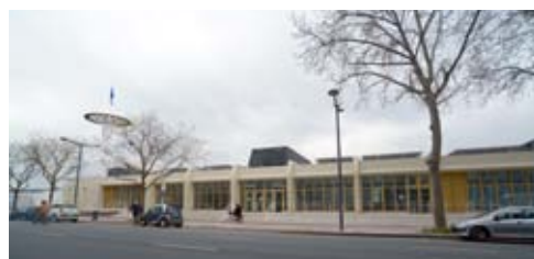
Installation solaire thermique au Centre Nautique du Rhône (7 ème arrondissement)
