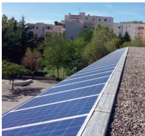
Panneaux Photovoltaïques au Groupe Scolaire Montbrillant (3 ème arrondissement)
