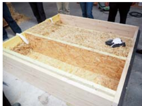
Préfabrication des murs en paille Gymnase Bon Lait (7 ème arrondissement)
