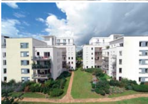
ZAC Valéo sud pendant et après travaux (8 ème arrondissement)
