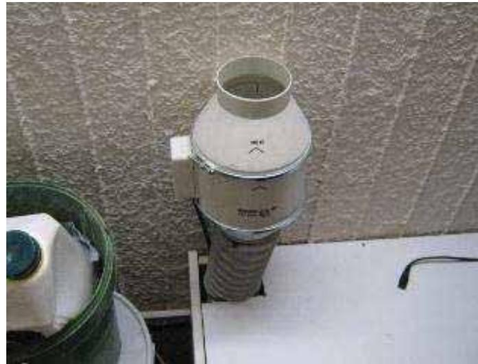
*Nuisances olfactives - système de ventilation d'une onglerie non conforme*
