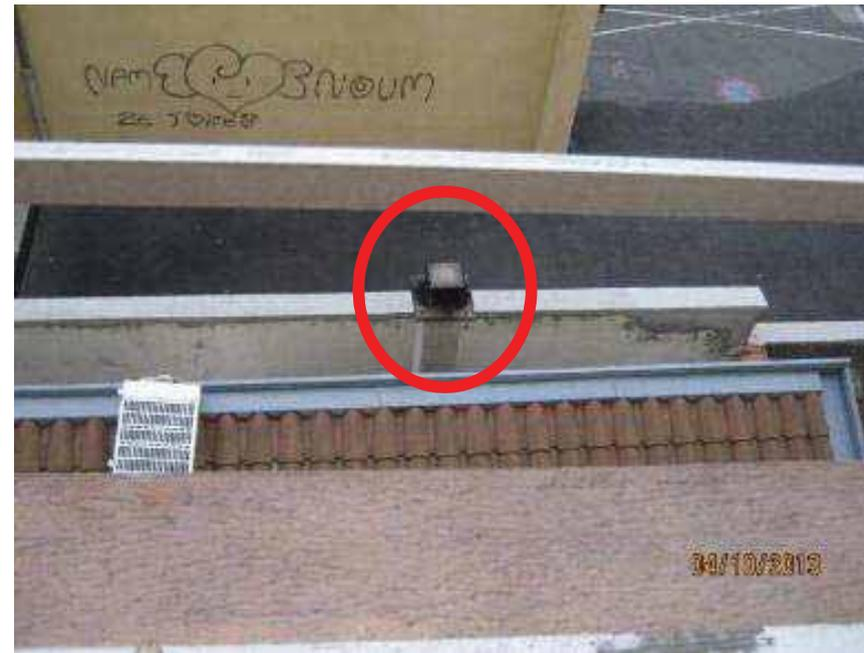
*Conduit de cheminée non conforme (distance de rejet inférieure à 8 mètres de tout ouvrant)*
