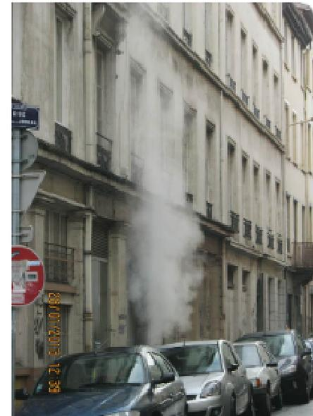
*Extraction d'air non conforme d'une boulangerie*
