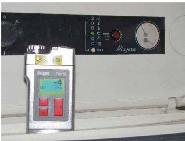
Equipés de détecteur de monoxyde de carbone, les techniciens réalisent des investigations in situ visant à mettre en évidence la cause de l'intoxication, prodiguent des conseils techniques, prescrivent des travaux pour éviter les "sur-accidents" et, le cas échéant, sollicitent la coupure immédiate du gaz auprès de Gaz de France.
