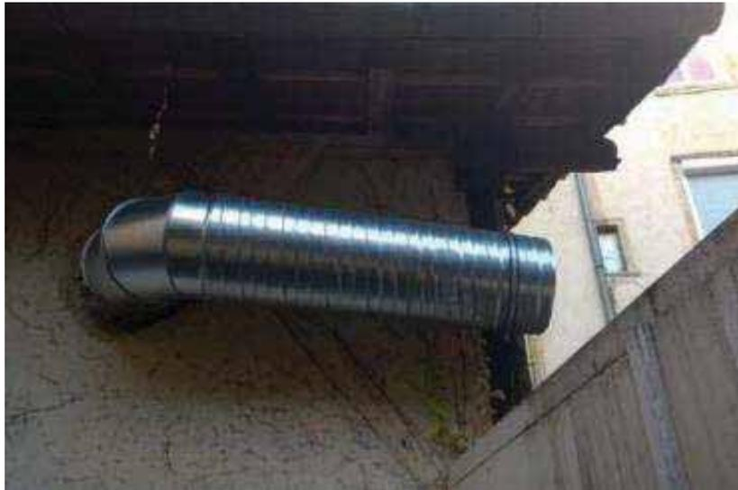
*Extraction d'air non conforme d'un restaurant*
