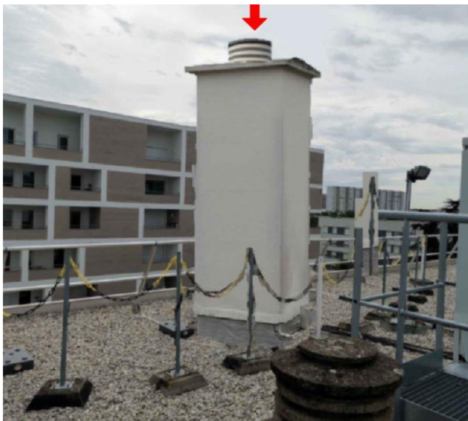
Vue de la terrasse après travaux
