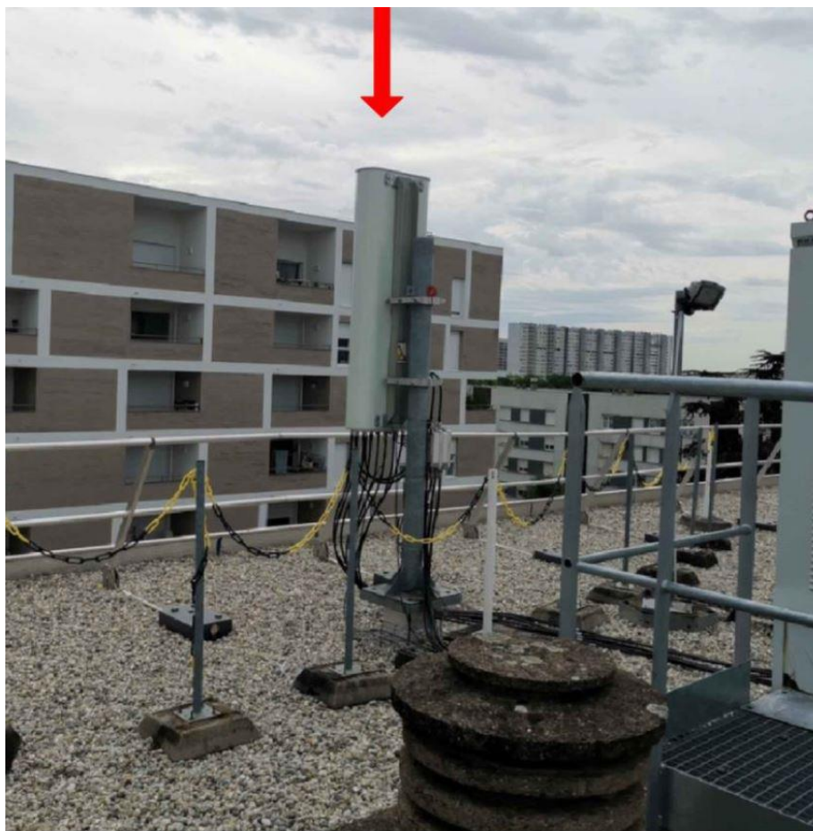
Vue de la terrasse avant travaux
