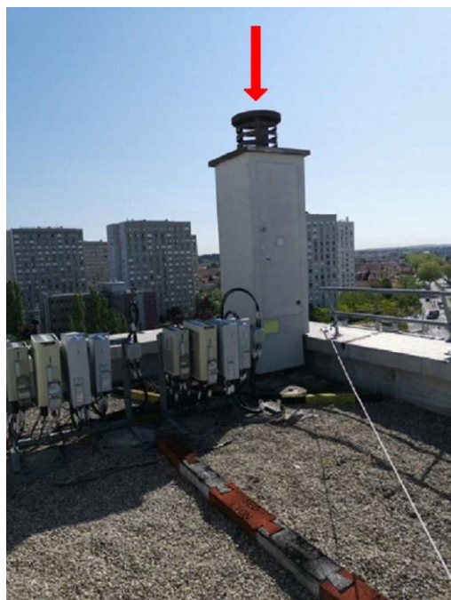
Vue de la terrasse avant travaux
