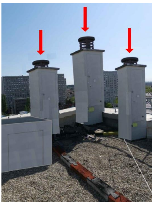
Vue de la terrasse après travaux
