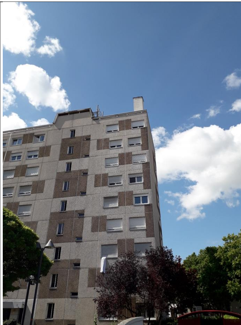
VUE 1 APRES TRAVAUX
