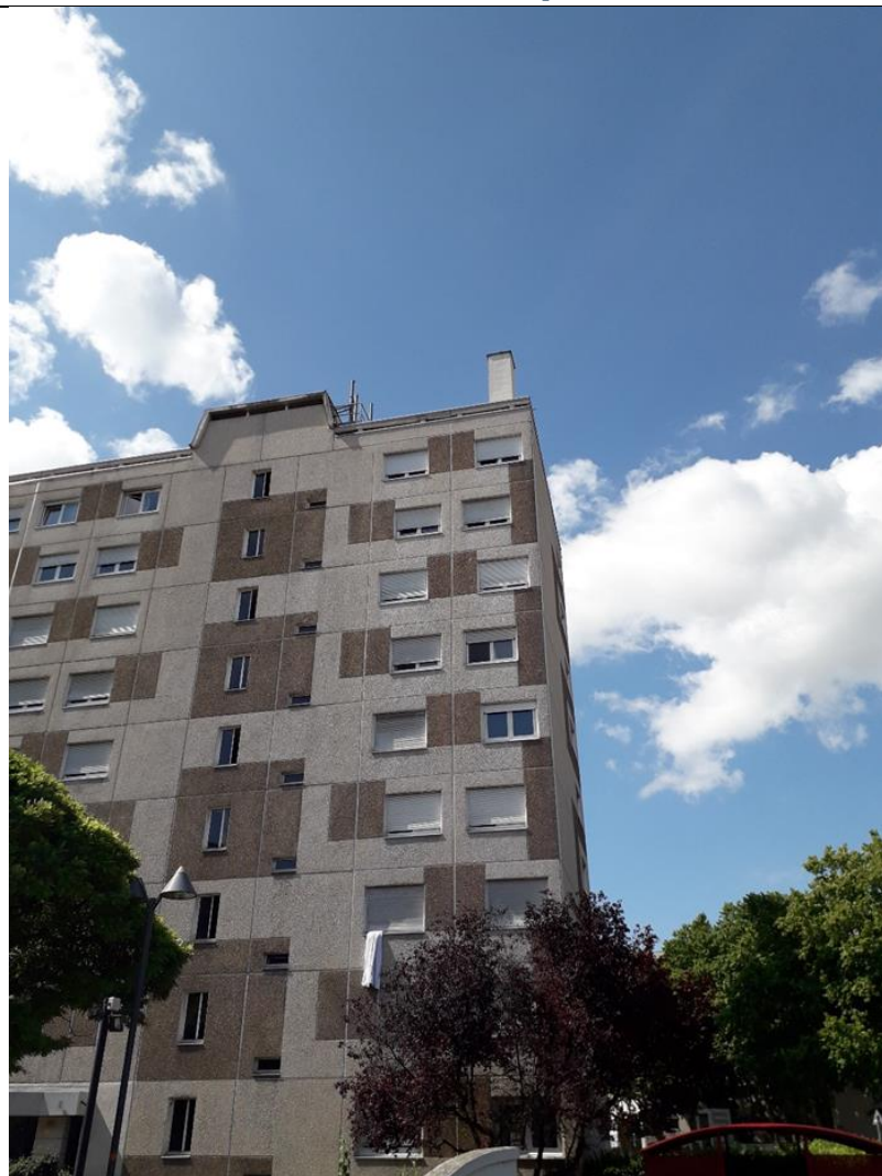
VUE 1 AVANT TRAVAUX
