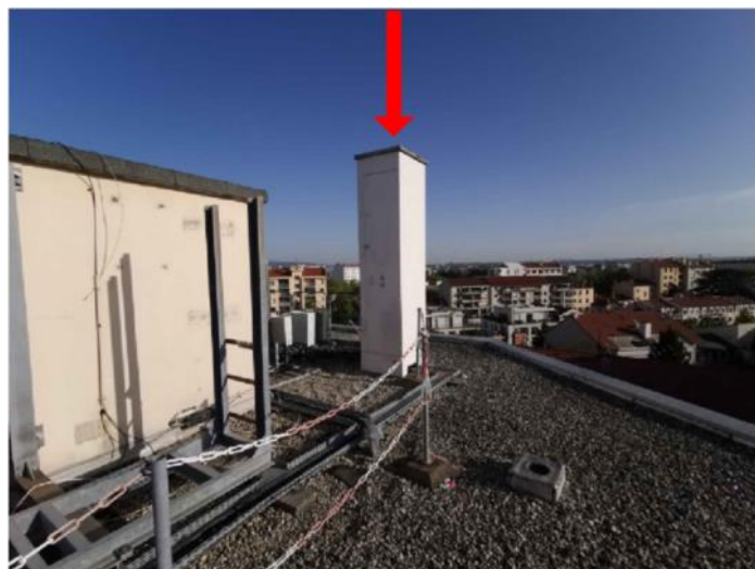
Vue de la terrasse avant travaux
