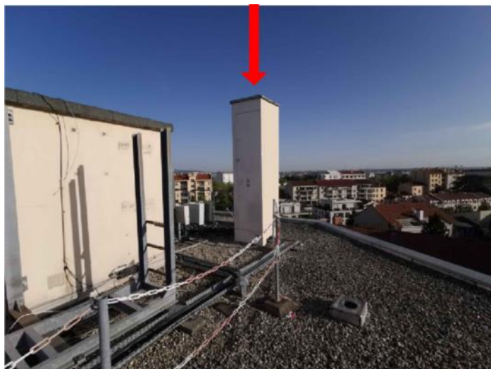
Vue de la terrasse après travaux
