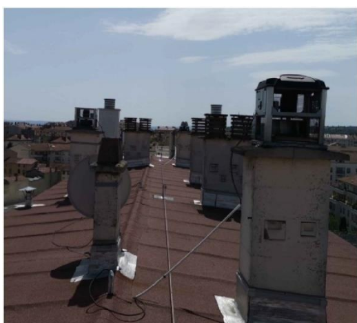
Vue de la terrasse avant travaux
