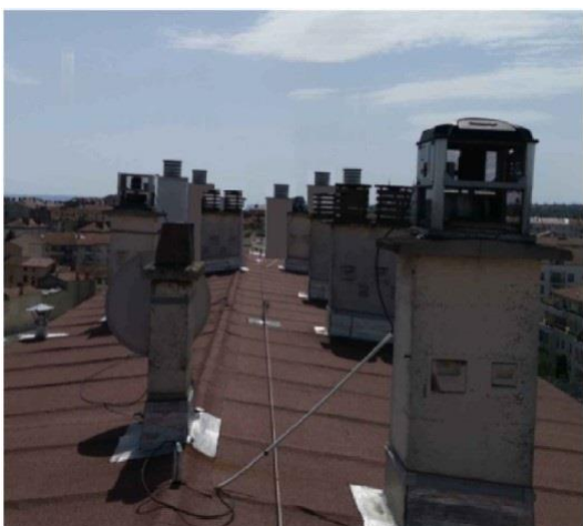
Vue de la terrasse après travaux
