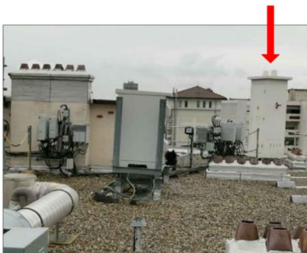
Vue de la terrasse avant travaux
