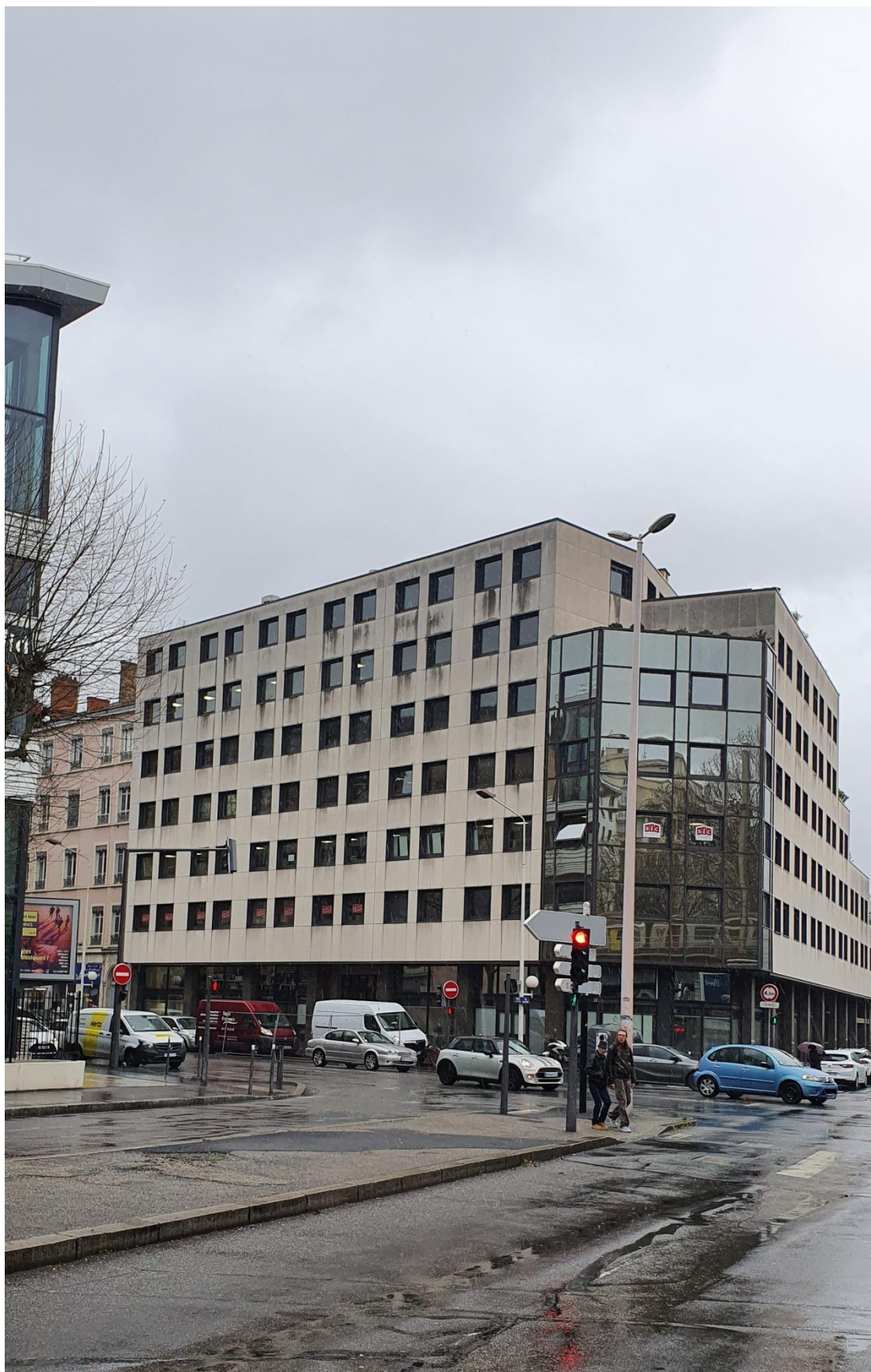
Figure 1. Vue de l'immeuble en façade
