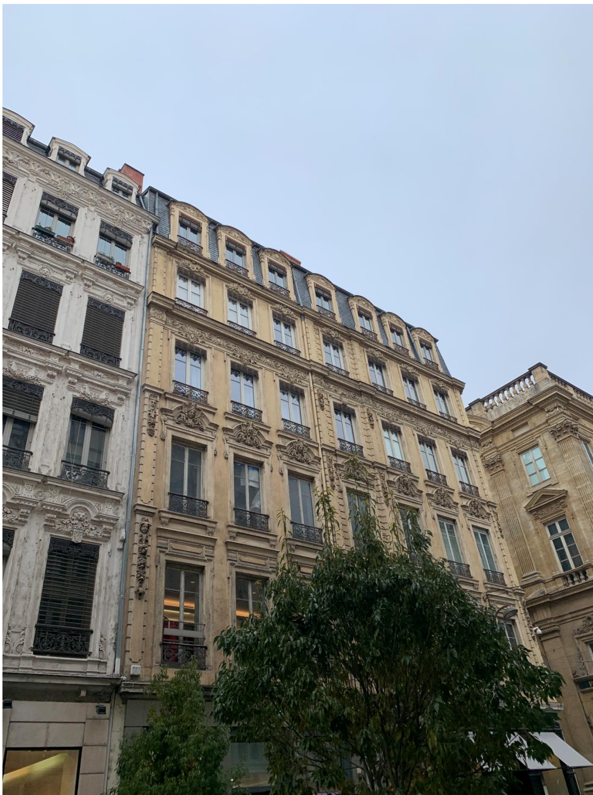
Figure 1. Vue de l'immeuble en façade
