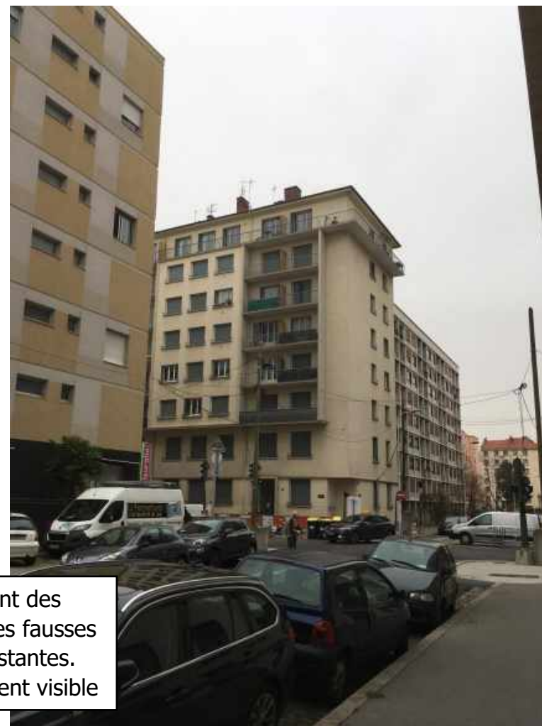
PHOTO DU SITE APRES TRAVAUX
