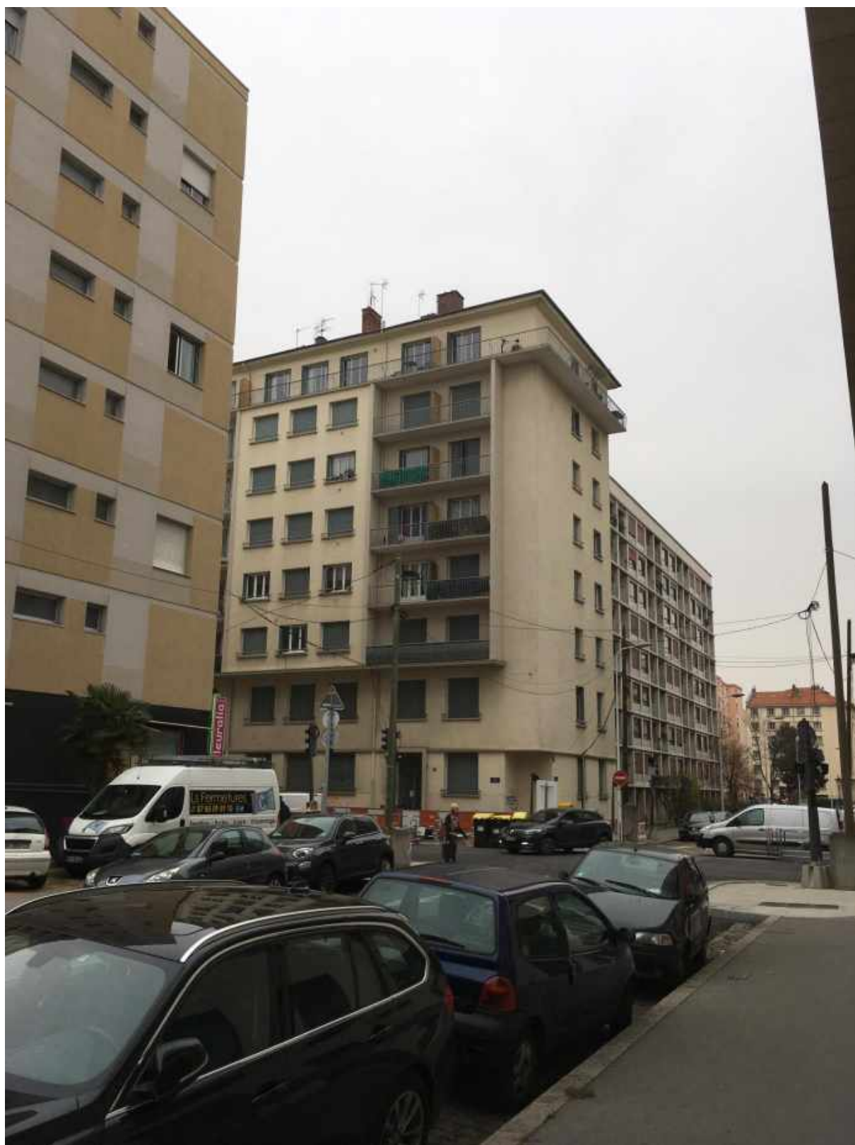
Figure 1. Vue de l'immeuble en façade
