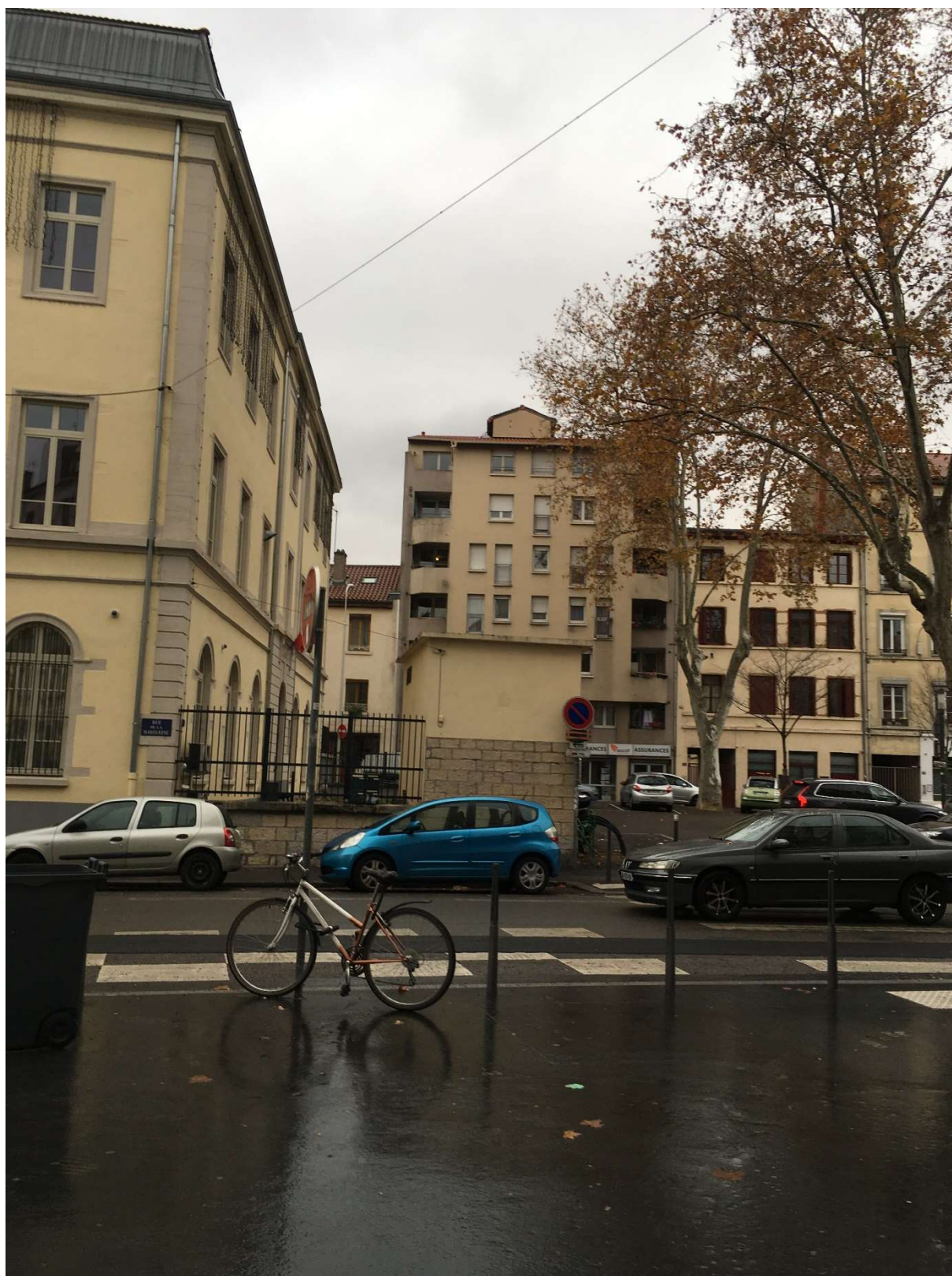
Vue de l'immeuble en façade
