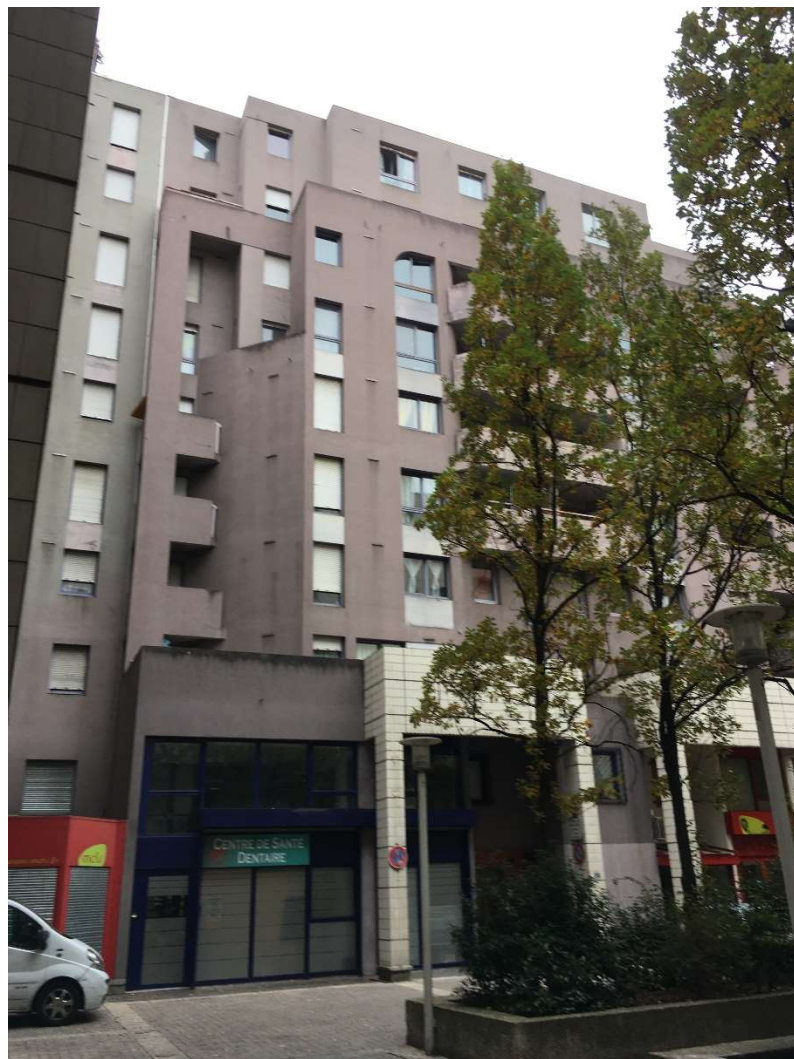
PHOTO DU SITE AVANT TRAVAUX (35 Boulevard Vivier Merle)
