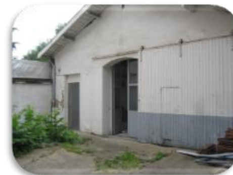
Changement de destination d'un entrepôt de stockage en bureaux
