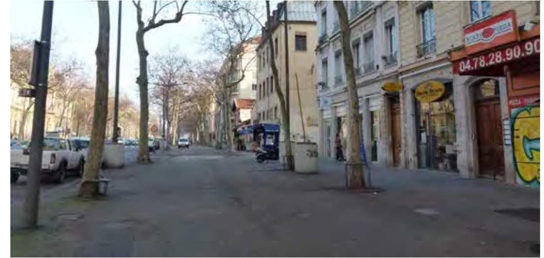
Sol asphalte et bordures centrales briques
