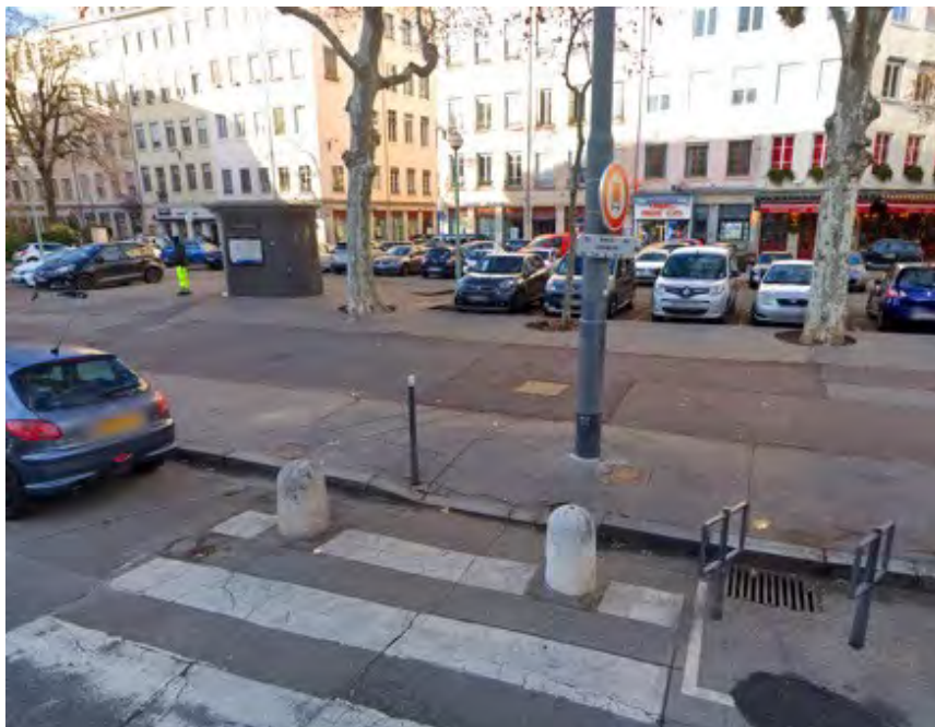
4 Bornes, rétrécissement de l'accès au trottoir, poteau LAC à l'arrivée sur trottoir qui compromettent l'accessibilité piétonne.
