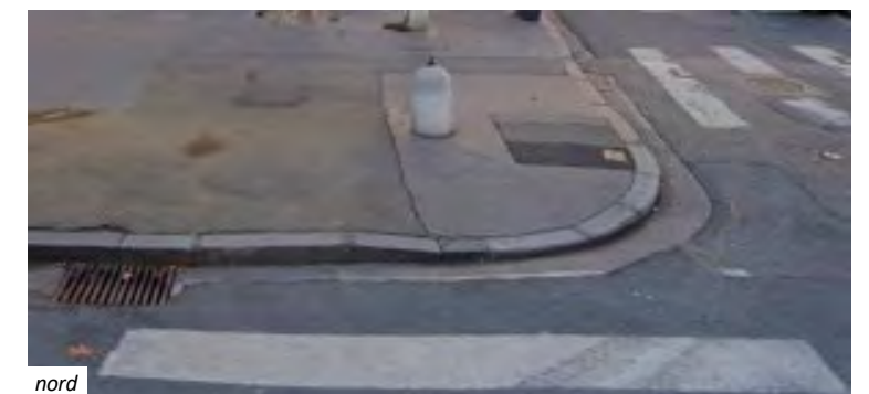
2 Trottoir surbaissé décalé et peu accessible, arbre et mobilité urbain encombrant l'arrivée du passage piéton
