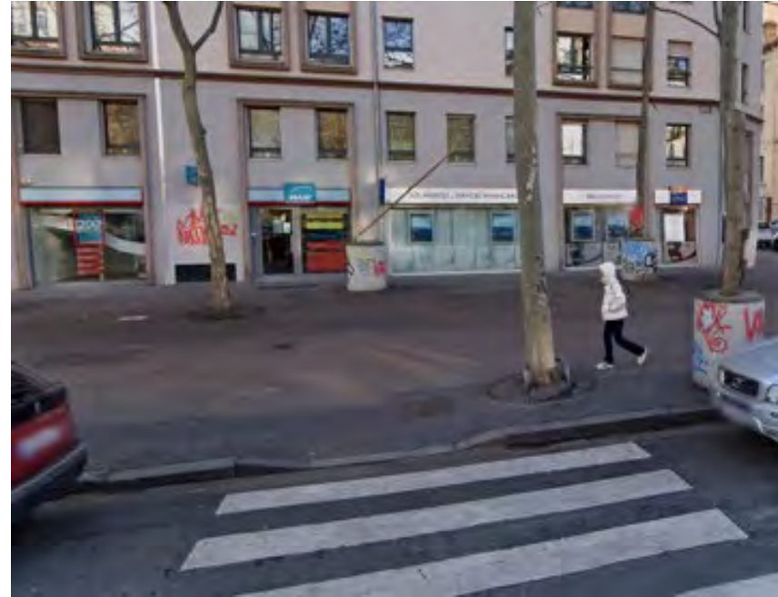
5 Rétrécissement du surbaissé de trottoir, pas de mobilier limitant le stationnement qui entoure le passage piéton.
