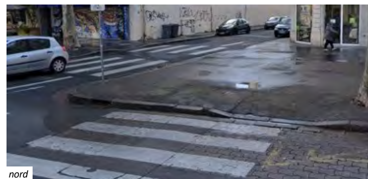
1 Poteau de signalisation en plein milieu d'arrivée de passage piéton, trottoir surbaissé décalé et étroit
